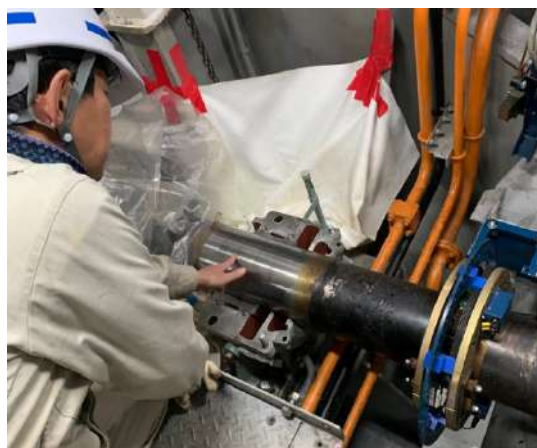
図2 中間軸開放点検の様子
