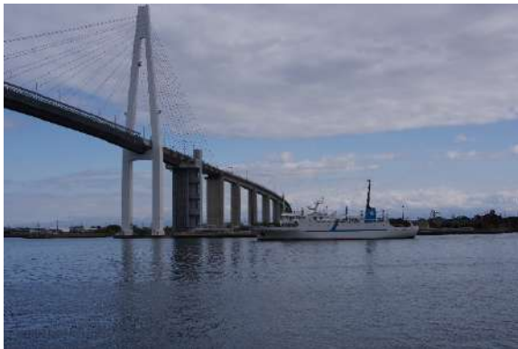
新湊大橋をくぐる4代目若潮丸
