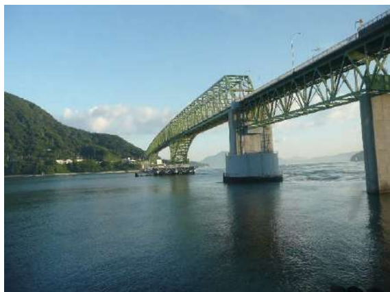
大島大橋（全長 1,020m）
