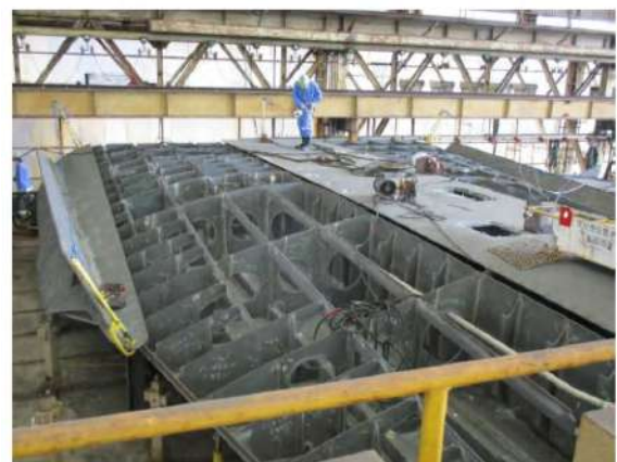
写真3 船体中央部二重底ブロック[反転状態] (2022/6/13)
