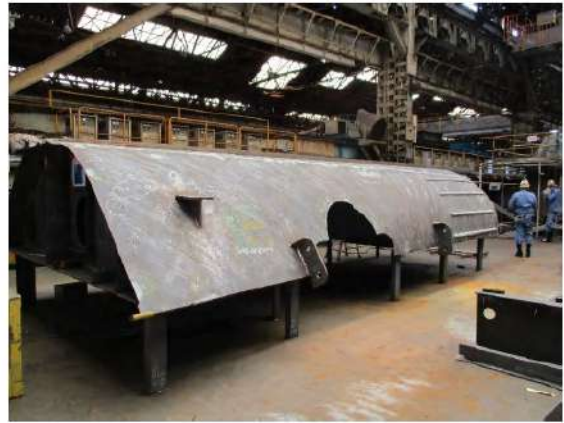
写真6 船首船底ブロック[反転状態] (2022/6/30)
