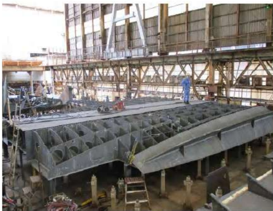
写真1 機関室二重底ブロック[反転状態] (2022/6/1)
