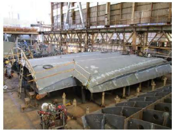
写真2 機関室二重底ブロック[反転状態] (2022/6/7)
