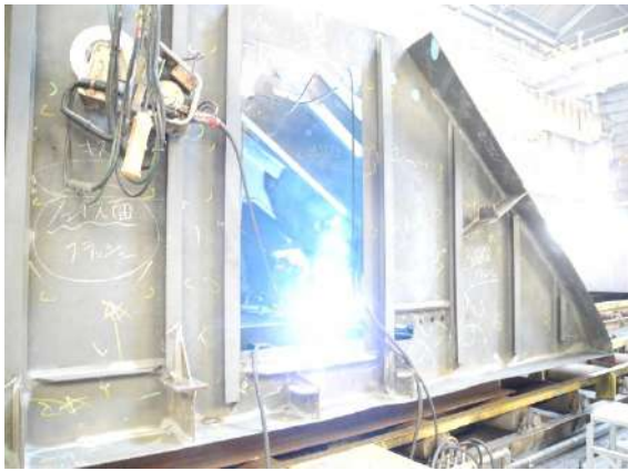
写真11 船殻溶接作業状況
