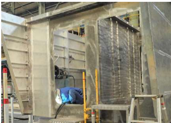
写真12 アルミ製構造物工事状況
