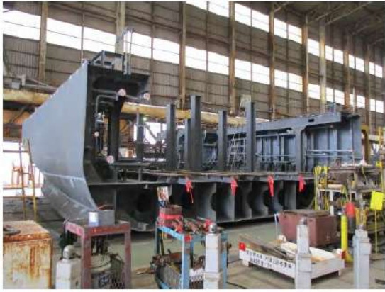
写真4 機関室二重底ブロック（写真1、2を経ての完成状況）(2022/6/20)
