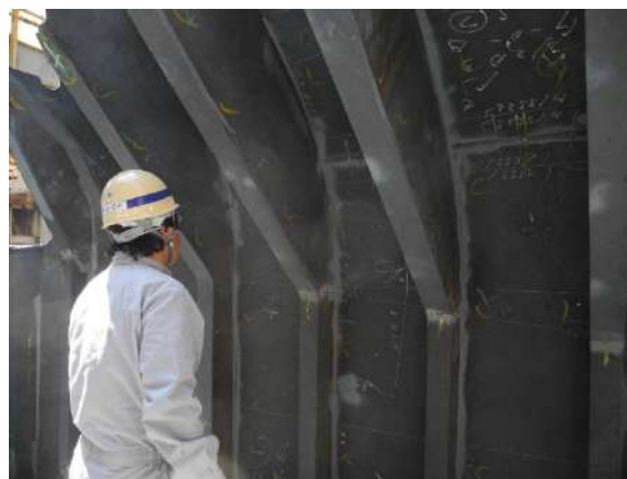
写真10 船殻工事検査
