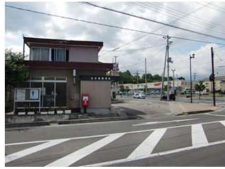
図 17 空き地が鵜殿屋敷跡（右奥白石城）
