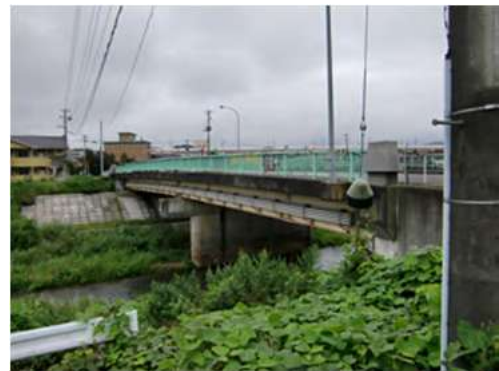
図 18 芥川に架かる雁狩橋
